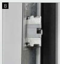
8 Zasuwnica GU rygłowanie górne
